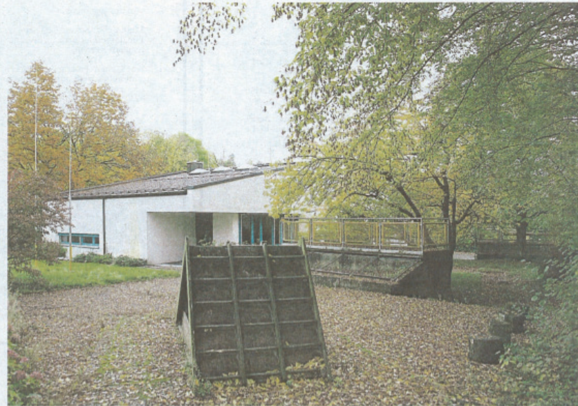
Über dem verwaisten Kindergarten Hofdürren deuten Baugesuche die Ausmasse der hier geplanten Gebäude an. Foto: Sabine Rock
